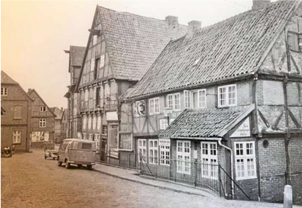
Der Hamburger Keller Anfang der 1960er-Jahre. Heute ist das verfallene Gebäude ein Schandfleck in der Altstadt Foto: Heimatbund
